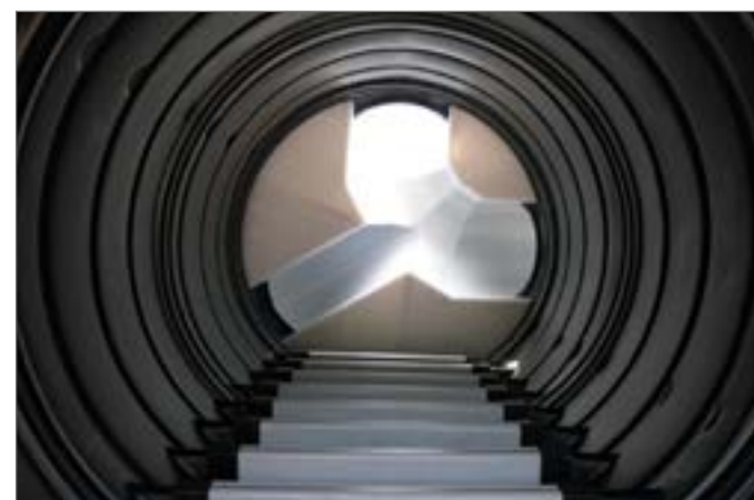
Studnia DN 1250. Kinetą kątową kanał DN 600 z dopływem bocznym.
