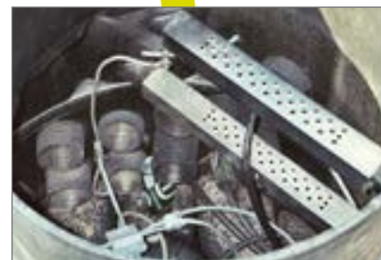
stopnie złączowe umożliwiające ewentualne zejście do studni, stopnie są demontowalne
