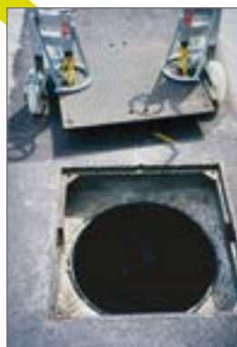
systemy gwarantujące szczelność - bazujące na podwójnej pokrywie.
