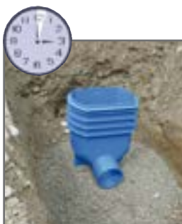
3. minuta: odpływ osadzony w chudym betonie
