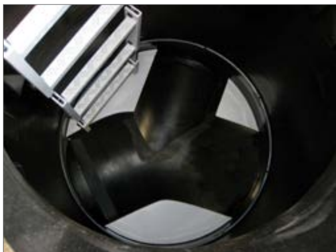
Studnia DN 1000 z kinetą DN 500 + dopływ boczny DN 400
