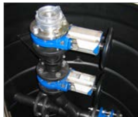
Studnia przetłaczająca DN 1000
