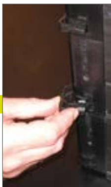
Podzielna w pionie, profil z narożnym łącznikiem, otwór drenażowy w płycie dolnej
