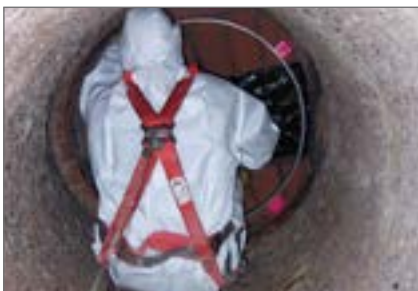
4.) Instalacja pierścienia montażowego na spoczniku
