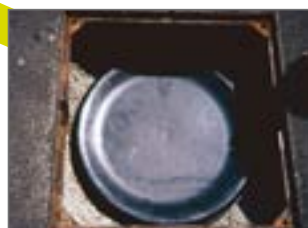
systemy gwarantujące szczelność - bazujące na podwójnej pokrywie.
