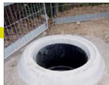
Posadowienie pierścienia odciążającego
