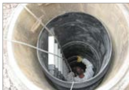
10.) Montaż pozostałych elementów studni PE DN 800 za pomocą uszczelek systemowych
