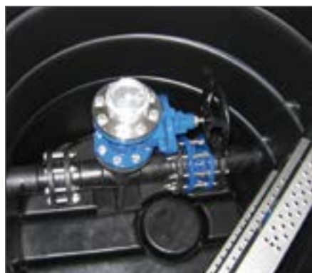
Studnia płucząca DN 1000 z 1 zasuwą
