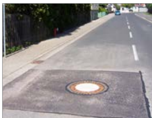
Odtworzenie nawierzchni drogi
