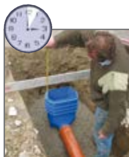
5. minuta: dokładne dopasowanie wysokości
