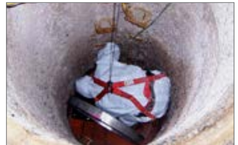
3.) Nacięcie asfaltu, demontaż betonowego stożka oraz stopni
