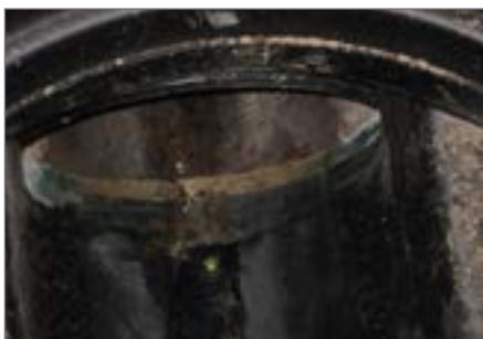
7.) Połączenie króćców PE z istniejącymi kanałami za pomocą zmodyfikowanej zaprawy
