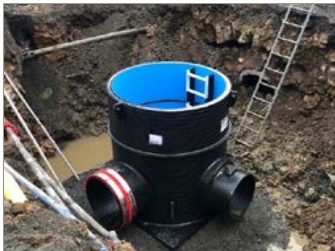
Studnia DN 1500 PE z kinetą DN 700
