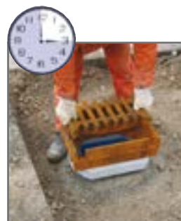
15. minuta: posadowienie kraty wpustowej
