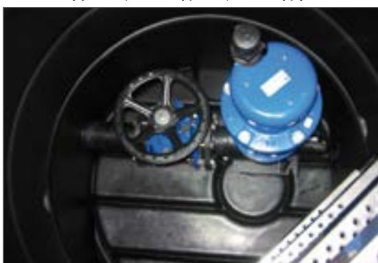
Kanał boczny jako odpowietrzająco-napowietrzający
