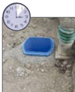
7. minuta: zasypanie i zagęszczanie
