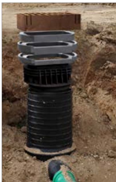
Późniejsze dopasowanie wysokości za pomocą pierścieni ROMOLD z tworzywa
