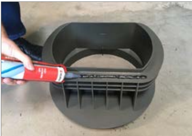
nałożenie kleju montażowego na wpust GRIT 40.50.30/13
