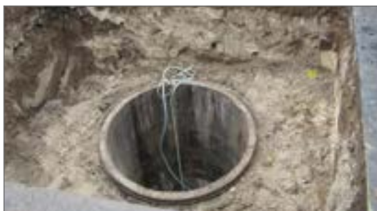
1.) Nacięcie asfaltu, demontaż betonowego stożka
