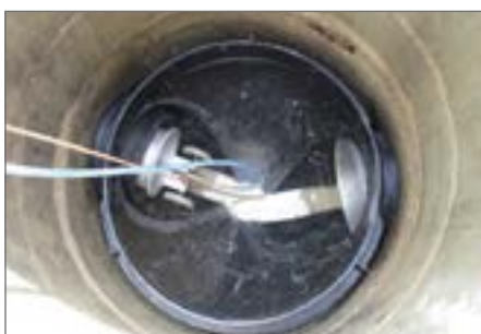
8.) Założenie korków (Quick Lock) na odpływie i dopływach
