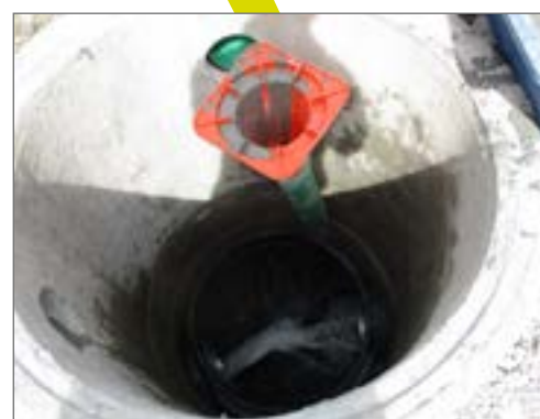
Wypełnienie przestrzeni między studniami
