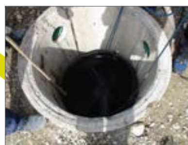
Posadowienie nowej podstawy w studni
