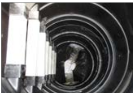
12.) Studnia po renowacji. Stopnie mogą zostać zdemonstrowane na życzenie klienta
