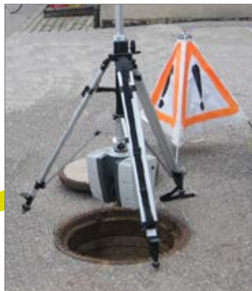
Szczegółowy pomiar istniejącej studni
