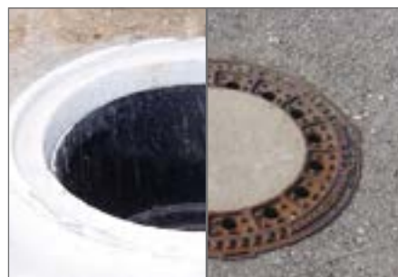
13.) Posadowienie pokrywy włazowej oraz odtworzenie struktury i nawierzchni drogi
