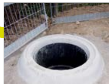
Posadowienie pierścienia odciążającego
