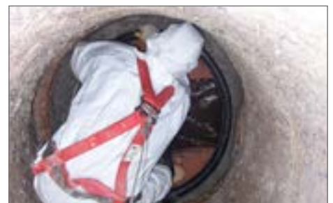
6.) Instalacja uszczelki elementowej ROMOLD na pierścieniu montażowym 100% szczelne połączenie z późniejszymi elementami
