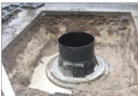
11.) Wypełnienie przestrzeni pomiędzy studnią PE DN 800 a studnią betonową DN 1000 zaprawą wypełniającą
