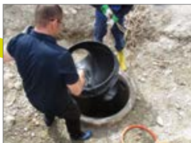
Posadowienie nowej podstawy w studni
