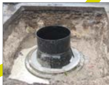
Wypełnienie przestrzeni pomiędzy studnią PE DN 800, a studnią betonową DN 1000 zaprawą wypełniającą
