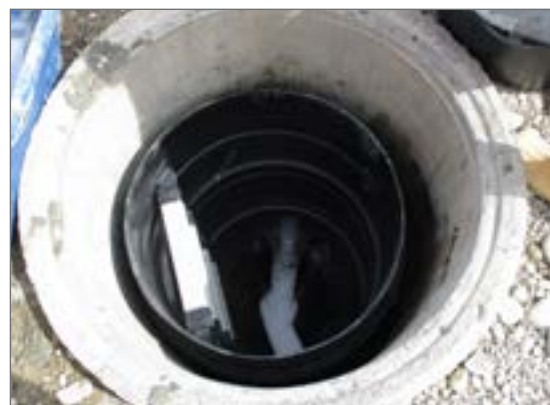
Renowacja: studnia w studni
