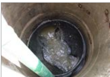
9.) Po utwardzeniu zaprawy, demontaż korków i udrożnienie przepływu
