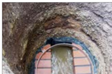
5.) Zamocowany pierścień montażowy
