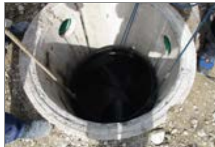
5.) Posadowienie kinety w istniejącej studni
