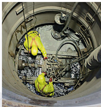
bezwykopowy montaż rur przewiertowych
