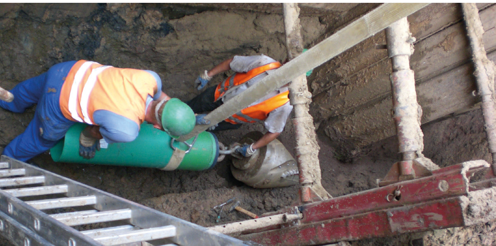
wciąganie pojedynczej rury przewiert horizontalny
