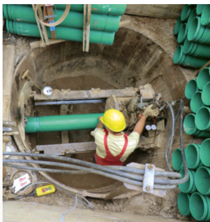
montaż za pomocą przewiertu pilotażowego
