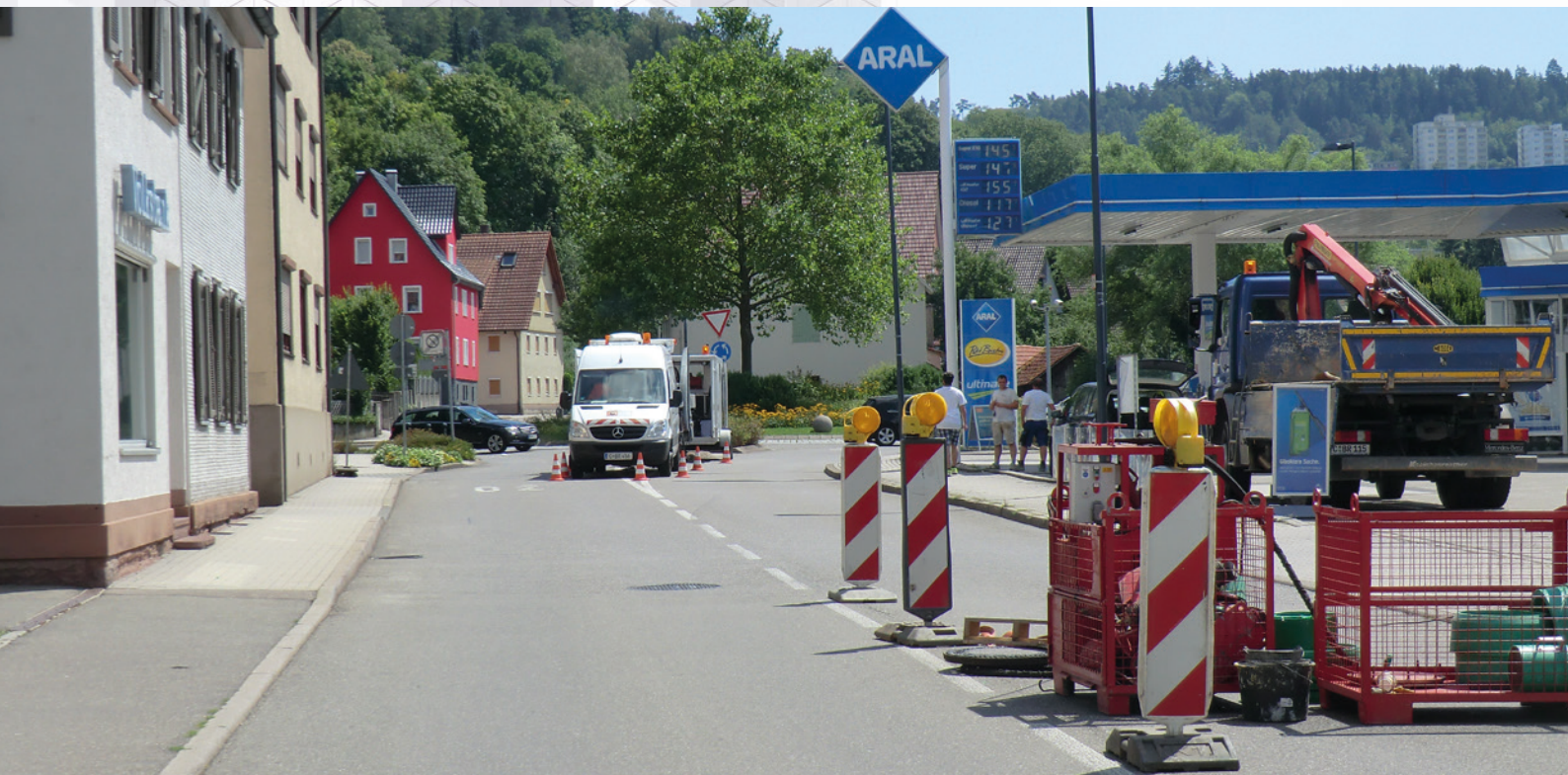
renowacja rurociągu ze studni do studni
