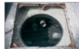
Wodoszczelny system przykryć z oddzielną pokrywą uszczelniającą oraz oddzielną pokrywą nośną.
