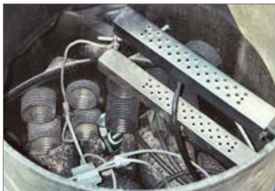
Stopnie mogą być zdemontowane, jeżeli wymaga tego np. instalacja kabla lub inne względy.
