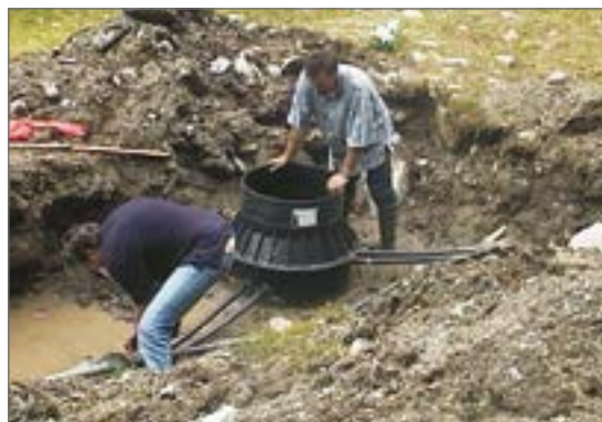
Telekom Austria: posadowienie studni ROMOLD w ciężkich warunkach gruntowych
