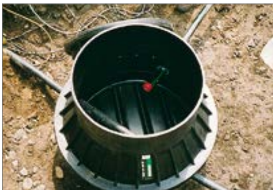
Energia AG Austria: wprowadzenie światłowodu
