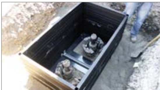
ROM-Box do armatury przesyłowej w sieciach ciepłowniczych.
