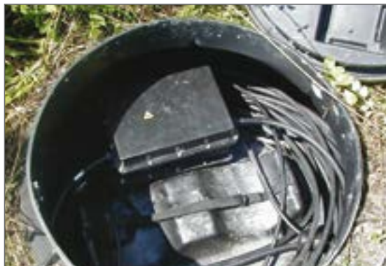
Koleje Czeskie: układanie bez dźwigu na trasie kolejowej
