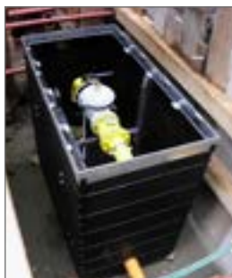
ROM-Box do prefabrykowanego zestawu armatury gazowej.
