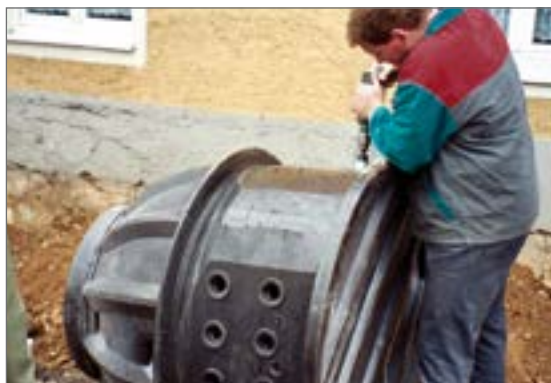
Przyłącze do rur i montaż uszczelnień na miejscu.
