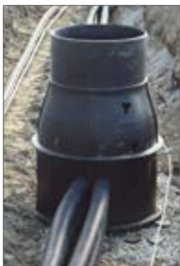
Budowa drogi komunalnej
