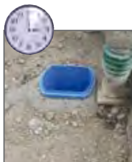
7. minuta: zasypanie i zagęszczanie
