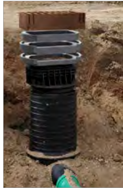
Możliwość regulacji wysokości za pomocą pierścieni ROMOLD PDRD
