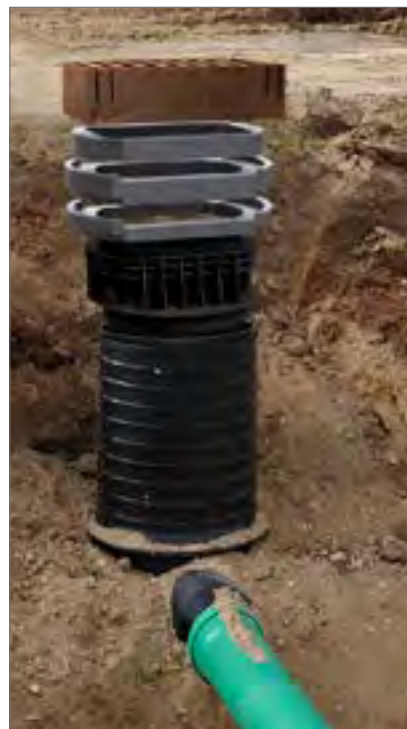
Późniejsze dopasowanie wysokości za pomocą pierścieni ROMOLD z tworzywa PDRD
