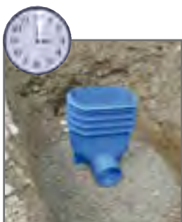
3. minuta: odpływ osadzony w chudym betonie
