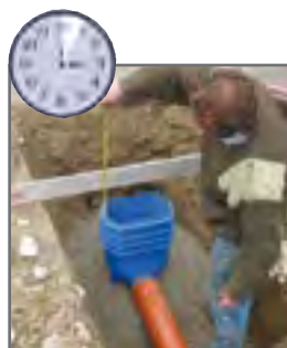
5. minuta: dokładne dopasowanie wysokości
