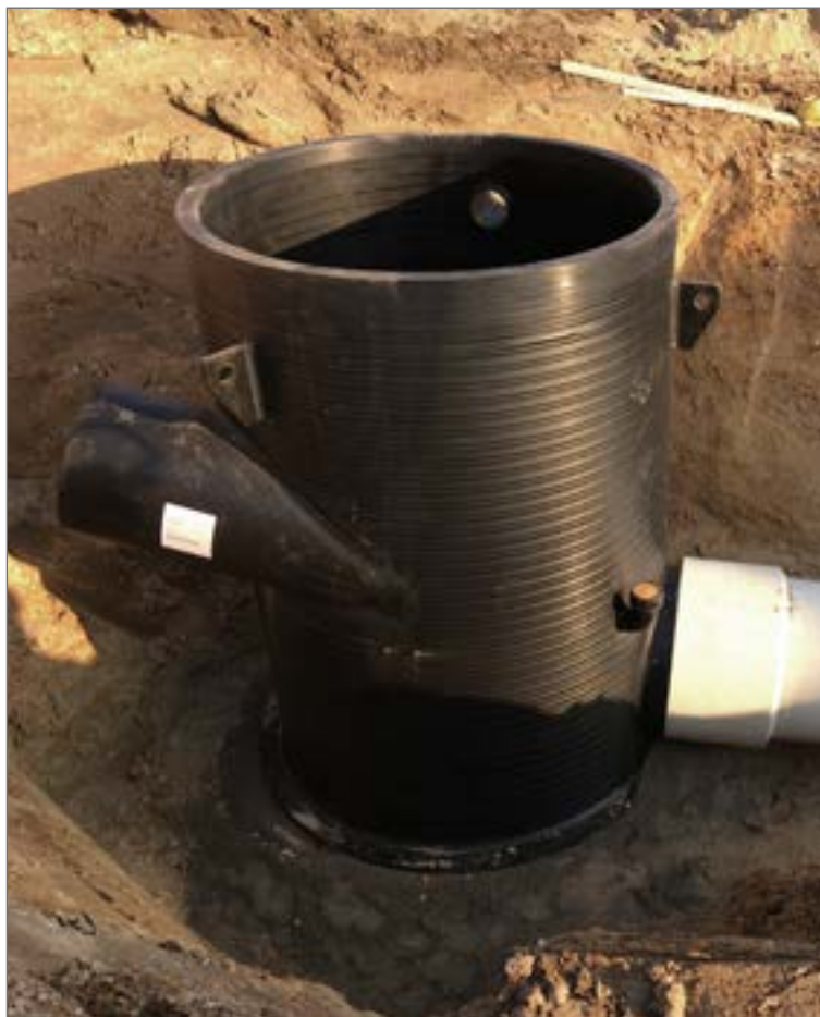
Przykładowa realizacja studni do wytracania energii DN 2000
